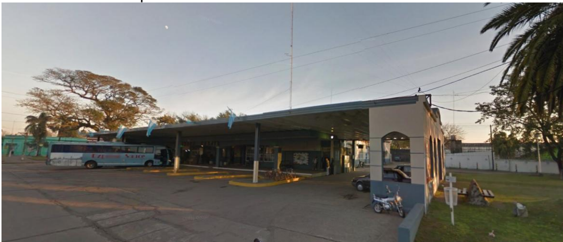
Figura 6 C. Vista acceso a andenes de actual Estación Terminal de Ómnibus desde calle Caa Guazú
