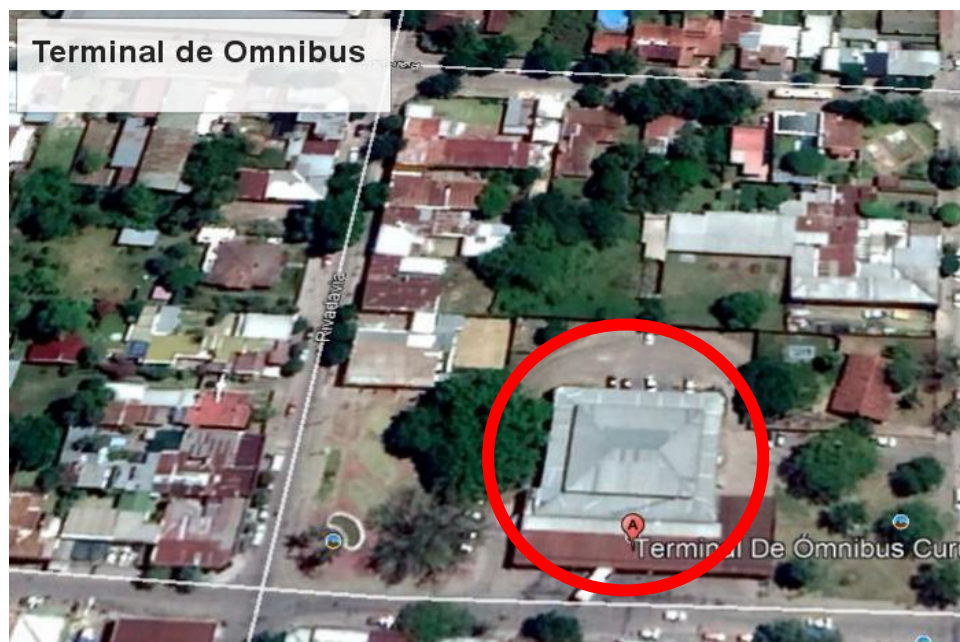
Figura 3. Vista más detallada de la Estación Terminal
