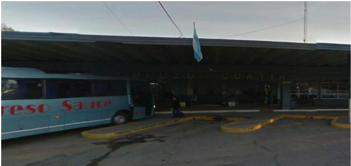
Figura 4. Estación Terminal (andenes)
